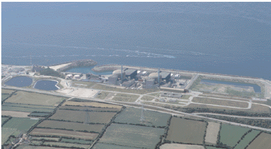
△ Vue aérienne du site de Flamanville.
