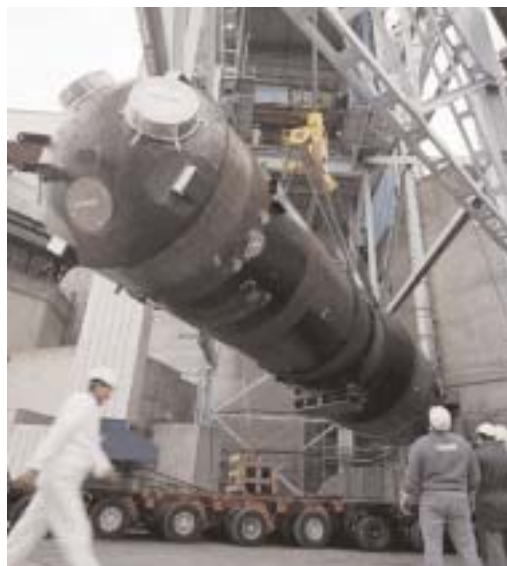
△ Manutention d'un générateur de vapeur.
