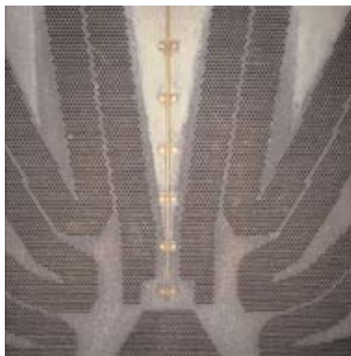
△ Les tubes du condenseur.
