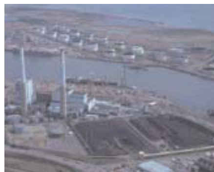
△ Centrale thermique du Havre.
